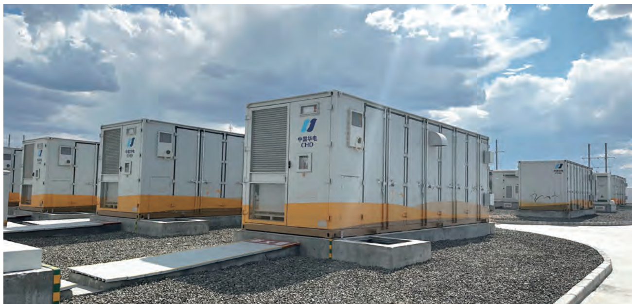
300MW/1200MWh 新疆华电天山北麓基地610万千瓦新能源项目
