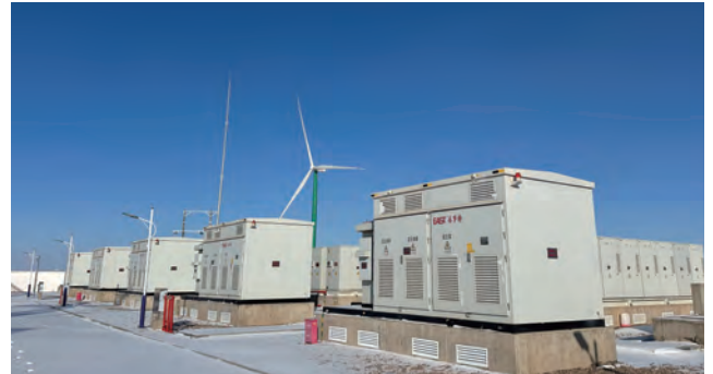
15MW/60MWh 张掖临泽板桥北滩一期100MW风电项目配储
