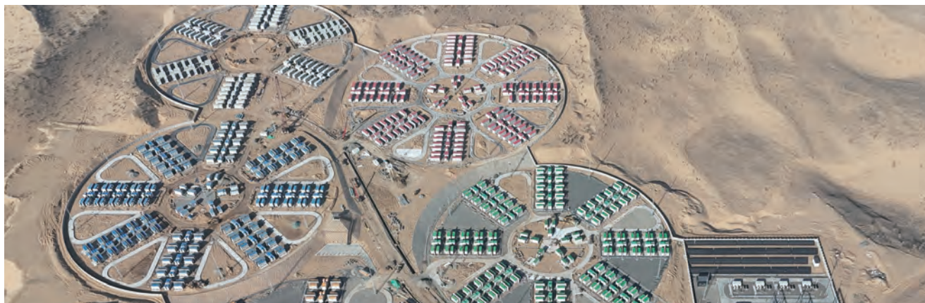
350MW/1400MWh 新疆华电乌鲁木齐光伏基地100万千瓦400万千瓦时独立储能
