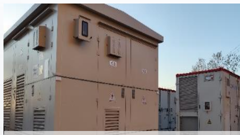
10MW/20MWh | 天津驰库
